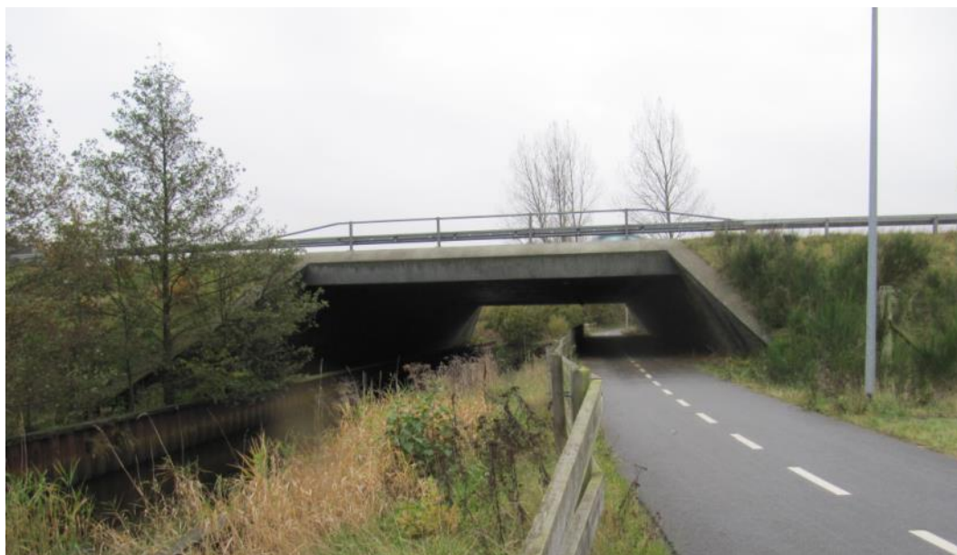
Figura 8 - Los murciélagos pueden usar túneles multifuncionales si hay poco tráfico humano y poca luz en el paso subterráneo durante la noche. Nunca se debe iluminar la vía de agua con farolas (Foto M. Elmeros).
