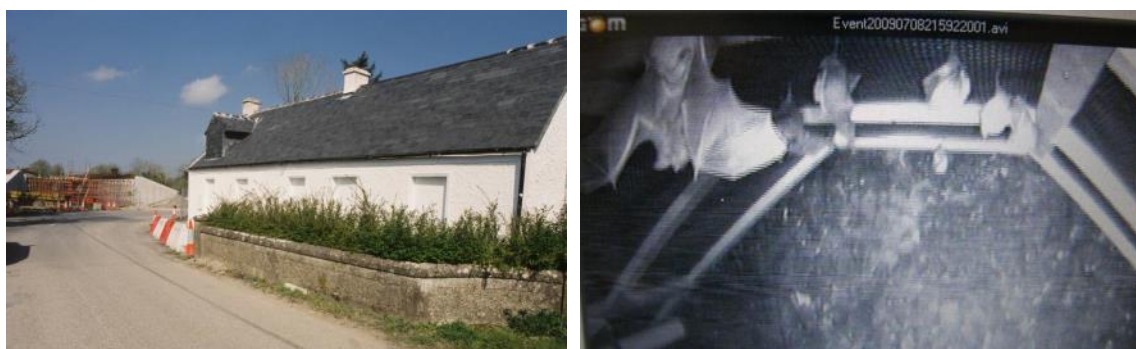
Figura 17 - La renovación de edificios existentes con refugios de murciélagos puede ser un método eficaz para proteger a las poblaciones de murciélagos cerca de carreteras (Fotos de V. O'Malley).
