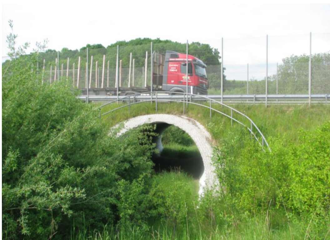
Figura 9 - Setos plantados para guiar a los murciélagos en el túnel bajo la carretera estatal S170n en Alemania. Las vallas altas (> 5m) en la carretera por encima del paso subterráneo mejoran la efectividad del paso para las especies de vuelo bajo y pueden funcionar como una pantalla para elevar el vuelo de las especies que vuelan a alturas medias y altas (Foto SWILD & NACHTaktiv).
