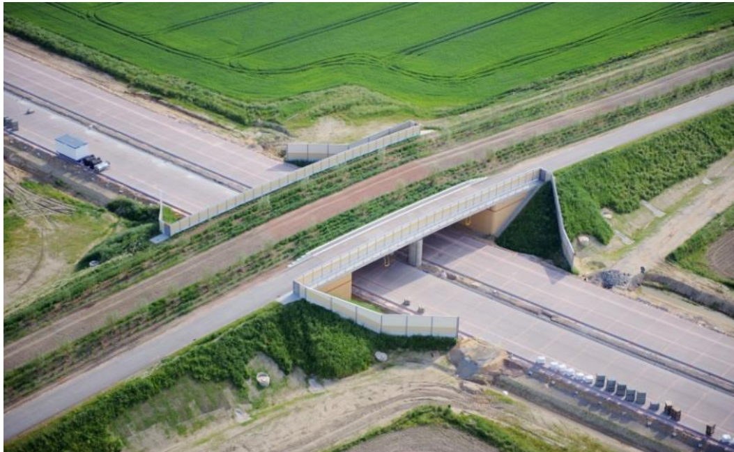
Figura 3 Puente de nueva construcción con pista de acceso agrícola bordeado por dos setos formando un corredor de vuelo para los murciélagos a través del BAB A14 en Alemania (Foto de Udo Tegethof).
