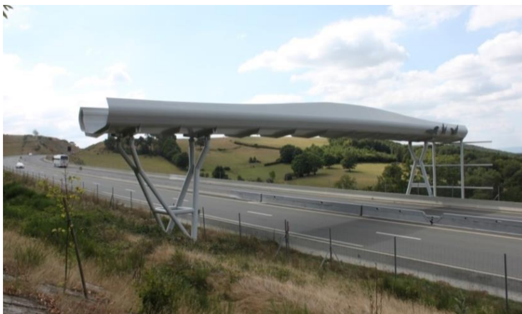
Figura 6 – Estructura de guía de vuelo para murciélagos en la A89 al oeste de Lyon en Francia. La estructura cerrada del pórtico puede proteger a los murciélagos contra el ruido del tráfico y la perturbación de la luz (Foto de M. Elmeros).
