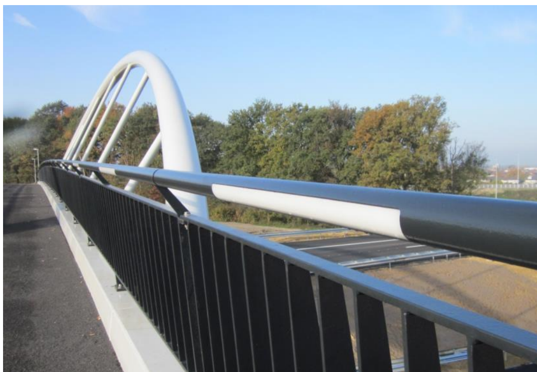
Figura 11 - La iluminación en este puente para bicicletas en los Países Bajos se ha instalado en la barandilla para reducir la iluminación del entorno y mantener una zona oscura a lo largo del puente para animar a los murciélagos a utilizarlo como un paso elevado seguro (Foto V. Loehr).
