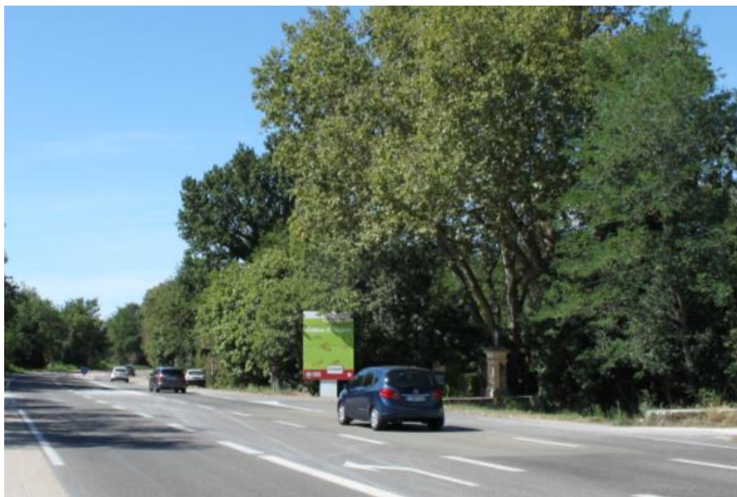
Figura 12 - Un sistema de alarma acústica instalado en un sitio con un alto número de cruces de murciélagos en un tramo de carretera de 37m de largo en la carretera regional RD530 en Francia. Cuando los coches pasan sobre tramos de asfalto poroso especial (tramo bajo el coche azul en la imagen) se genera un sonido de alta frecuencia para avisar a los murciélagos (Foto M. Elmeros).
