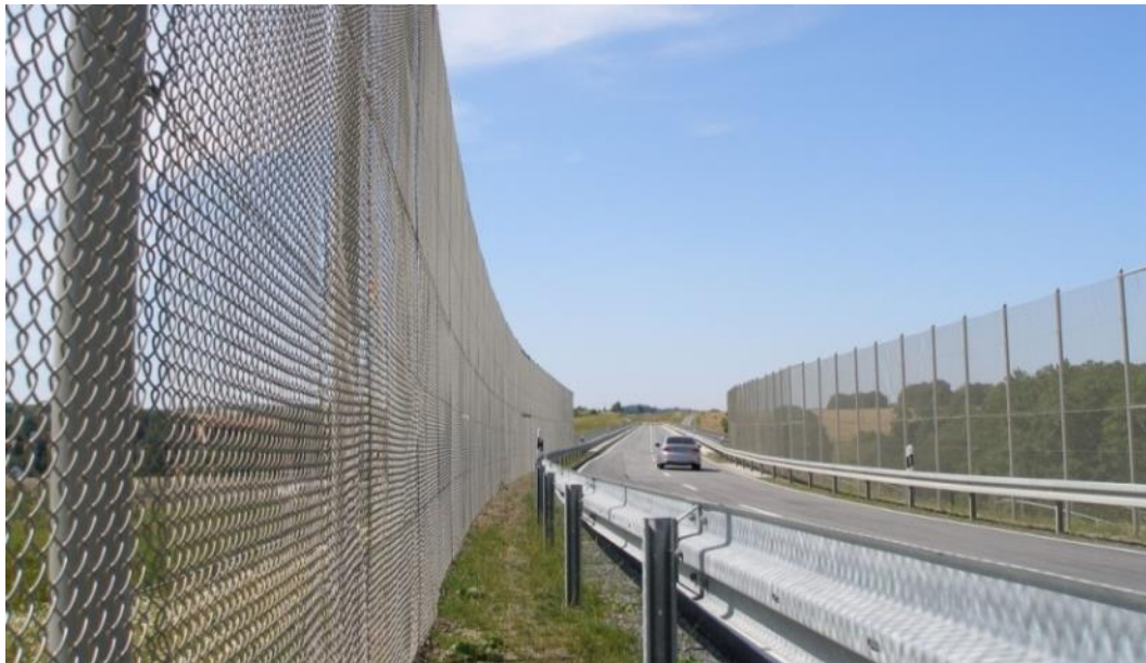
Figura 15 - Se necesitan vallas altas para guiar a los murciélagos con seguridad a través de la carretera por encima de la altura del tráfico. Las vallas de la fotografía están instaladas cerca de pasos inferiores en la carretera estatal S170n en Alemania (Foto SWILD & NACHTaktiv).
