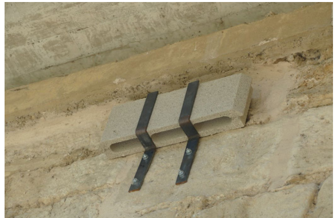
Fig. 1 - Bovedilla colocada en el puente de Miranda de Arga.
