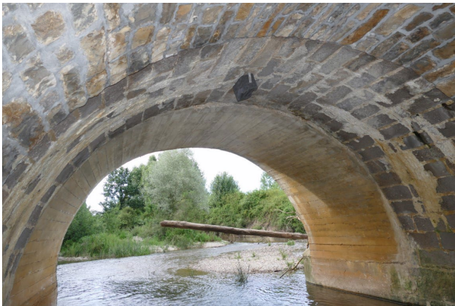
Fig. 3 - Caja 1GS colocada en un ojo del puente de Urroz-Villa.
