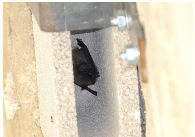
Fig. 2 - Murciélago ratonero ribereño en una bovedilla de hormigón.
