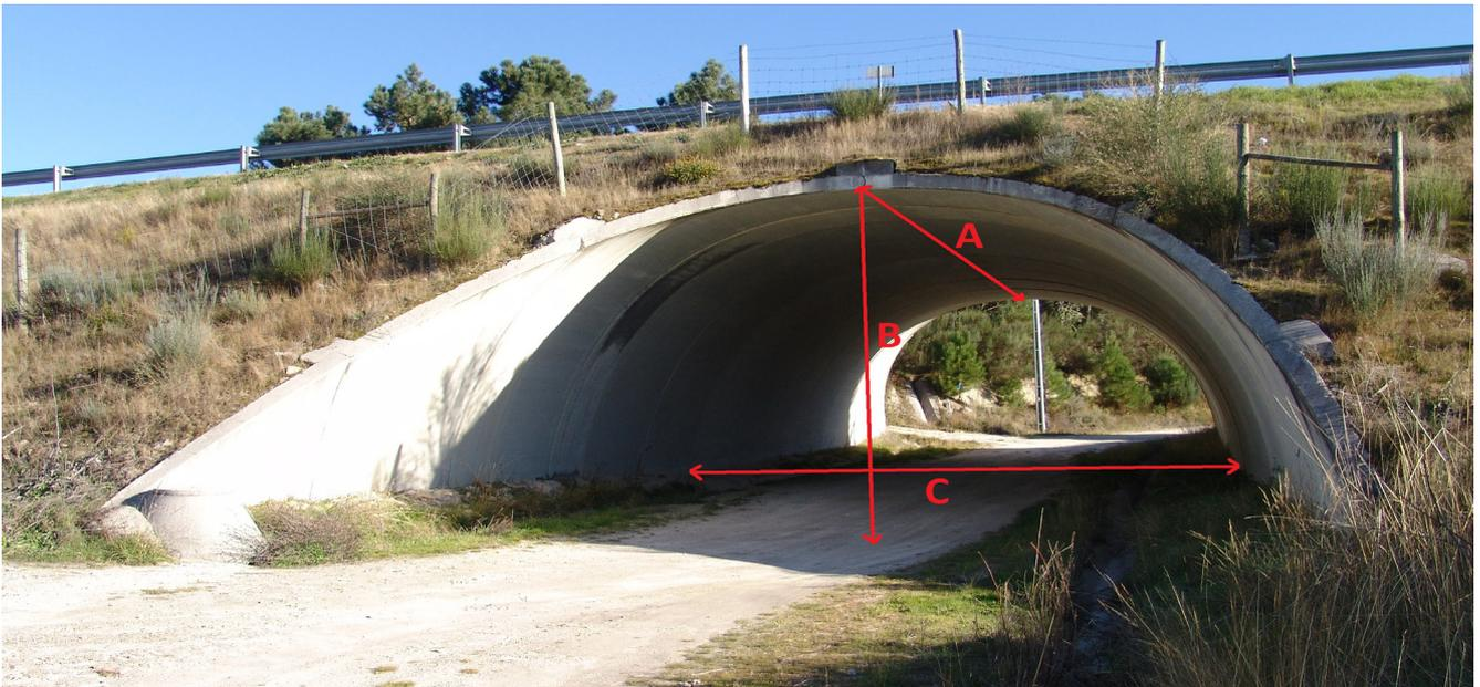
Fig. 2 – Tipología de los pasos (paso IV). Leyenda: A-longitud; B-altura; C-anchura
